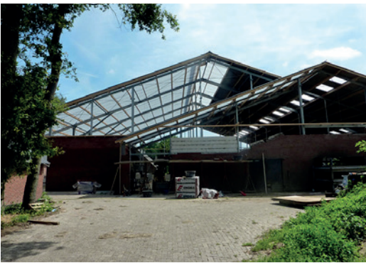
Halbes Dach mit Lichtplatten
