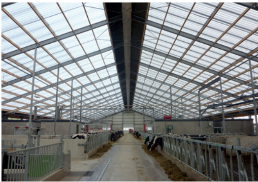
Völliges Dach mit Lichtplatten
